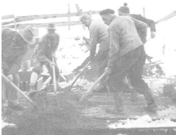
Bau der Klärgrube
