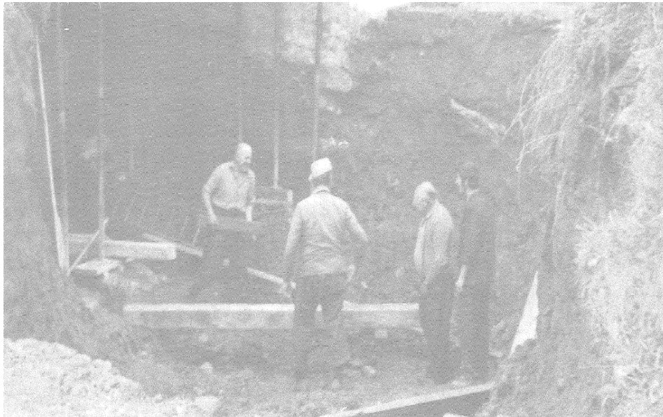
Bau der unteren Stube
